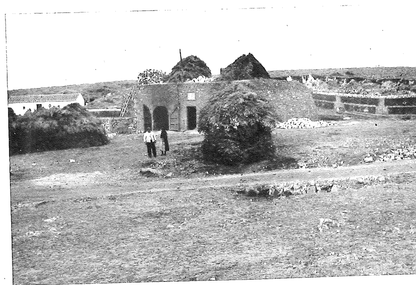
Hornos de cal en el calerizo devoniano de Aldea Moret. El horno está en el momento de carga.
